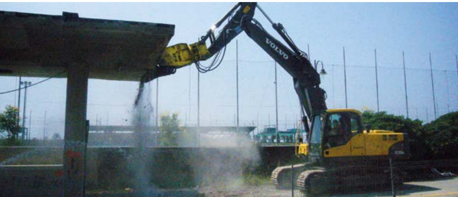
Demolizioni speciali. Demolizioni con pinza idraulica.
