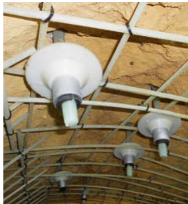
Regione Sardegna - Comune di Porto Torres. Opere di consolidamento della grotta a mare Renaredda mediante chiodature e placcaggio in vetroresina.
