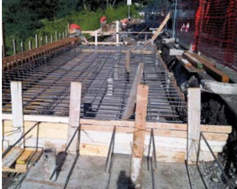
Città Metropolitana di Genova - ex Provincia. SP 225 della Val Fontanabuona. Lavori di allargamento sede stradale.
