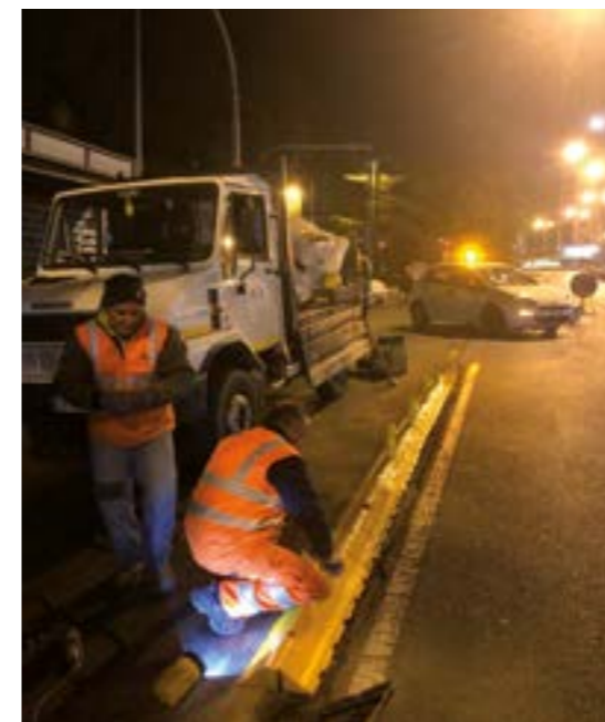
Aster SpA. Lavori di manutenzione stradale - Comune di Genova.
