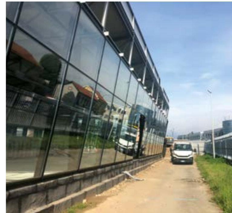
Spazio Group SpA - Torino. Costruzione di due nuovi autosaloni Toyota e Lexus in via Ala di Stura - Torino
