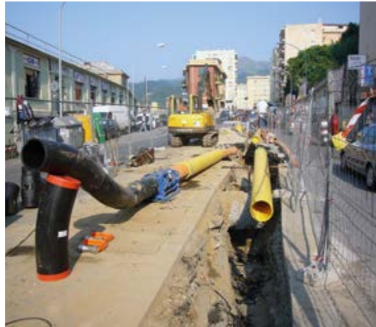
IREN SpA - Genova. Rinnovamento rete gas - scavi e posa in opera nuove linee zona Genova ponente.
