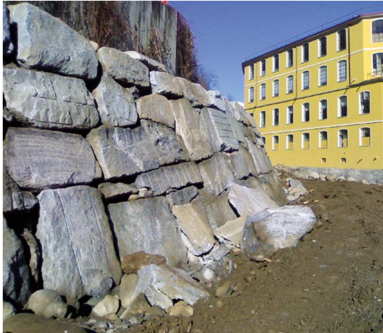
Comune di Biella. Sistemazione idraulica e costruzione di argine in scogliera sul torrente Cervo.
