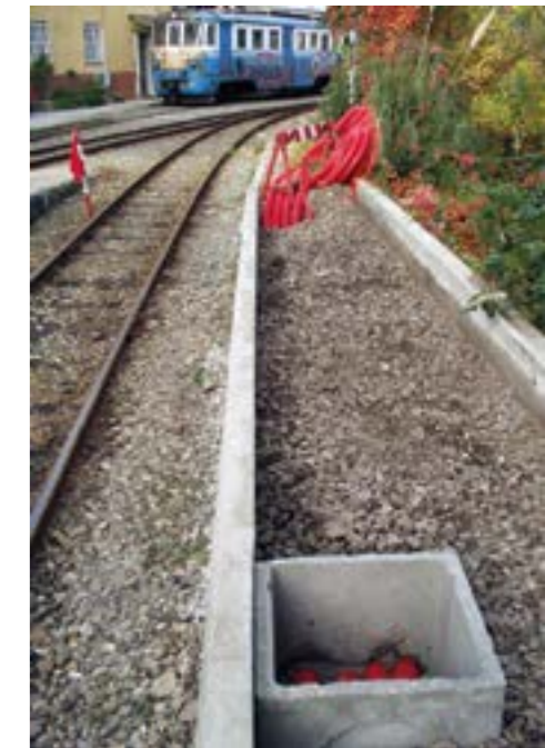
Regione Liguria - Ferrovia Genova Casella. Ristrutturazione edile e ferroviaria della stazione capolinea di Genova.
