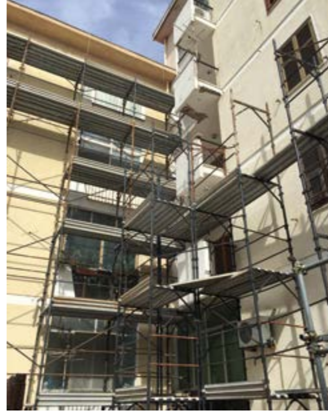
Comune di Sassari. Manutenzione immobili di proprietà del Comune. Coperture e facciate in via Dei Gremi 8 - 10 - 12.
