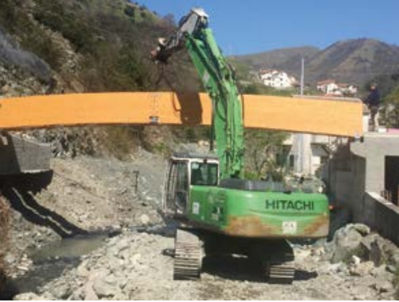
Comune di Genova. Opere idrauliche e strutturali di arginatura del torrente Varenna e costruzione della nuova passerella pedonale in località San Carlo di Cese.
