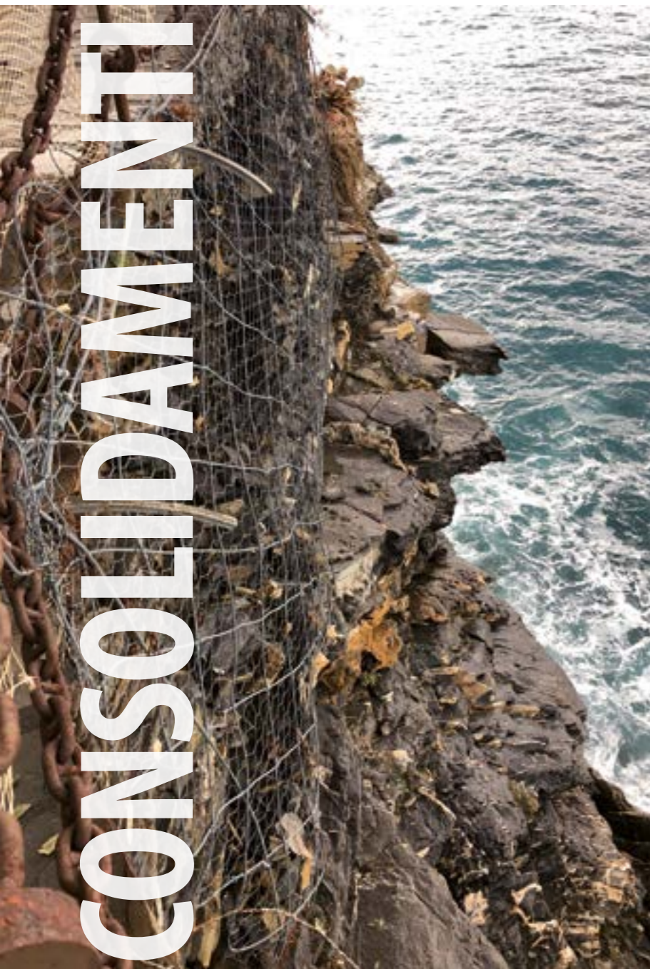
Comune di Sori. Opere di consolidamento fronte mare.
