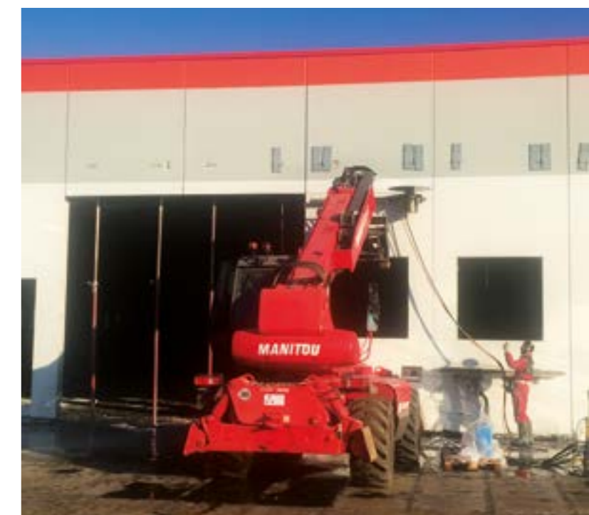
Demolizioni speciali. Taglio di cemento armato con disco diamantato.
