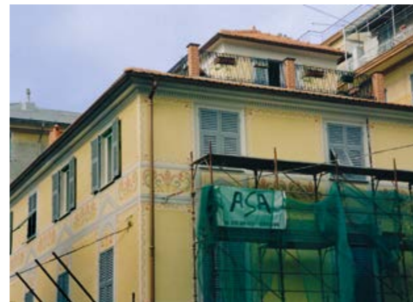
Genova. Immabile in via Martiri della Libertà. Rifacimento copertura e terrazzo, restauro con affreschi della facciata.
