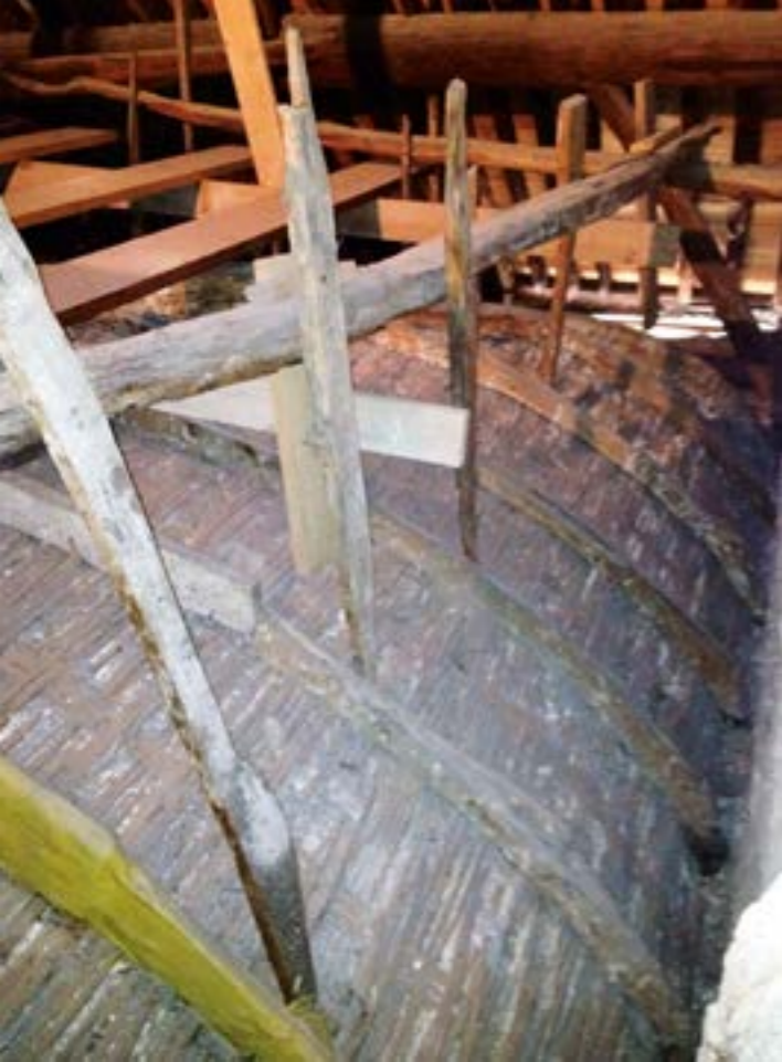
Comune di Genova. Lavori di risanamento delle volte in Villa Sciallero mediante tiranti in acciaio inox e rinforzi in fibra di carbonio.
