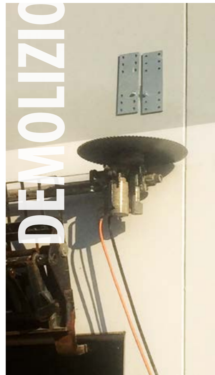
Demolizioni speciali. Taglio di cemento armato con disco diamantato.
