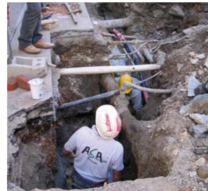
Comune di Genova. Costruzione stazione di pompaggio acque giardini Melis - Genova Cornigliano.
