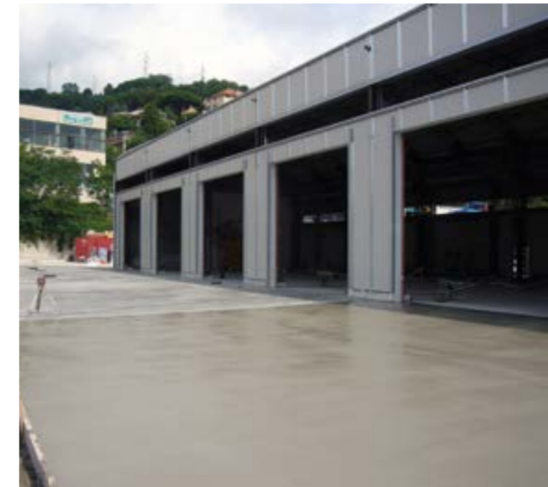
Rolls Royce Motori Marini - Genova. Costruzione di nuovo capannone riparazioni.
