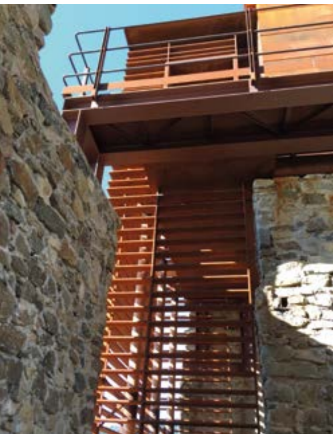
Comune di Noli. Restauro del complesso monumentale Castello di Monte Ursino.
