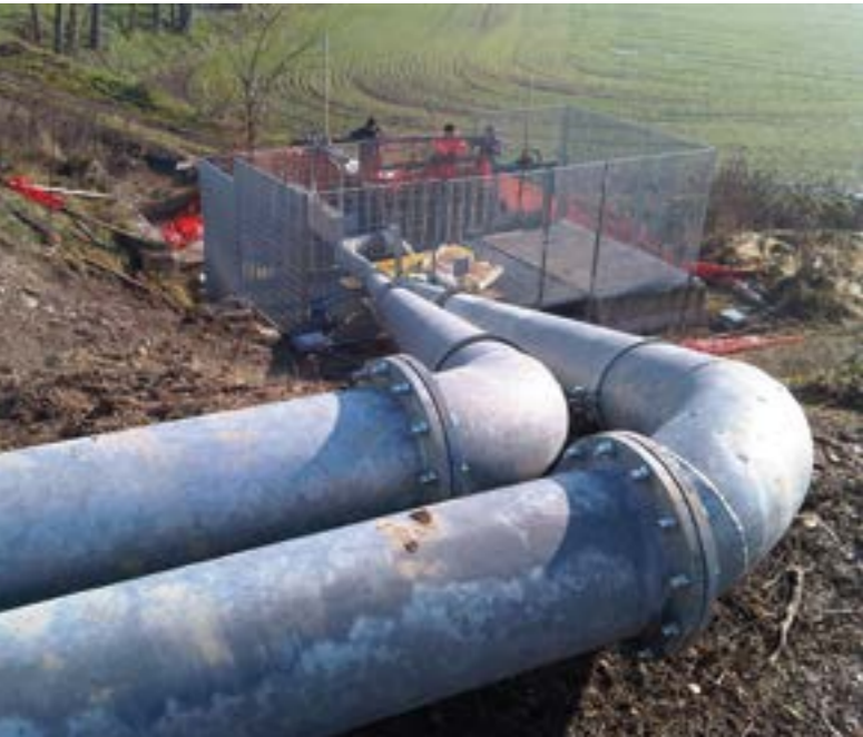
ANAS Torino - Comune di Alessandria. Impianto di sollevamento acque per sbarramento esondazioni fiumi Bormida e Tanaro.
