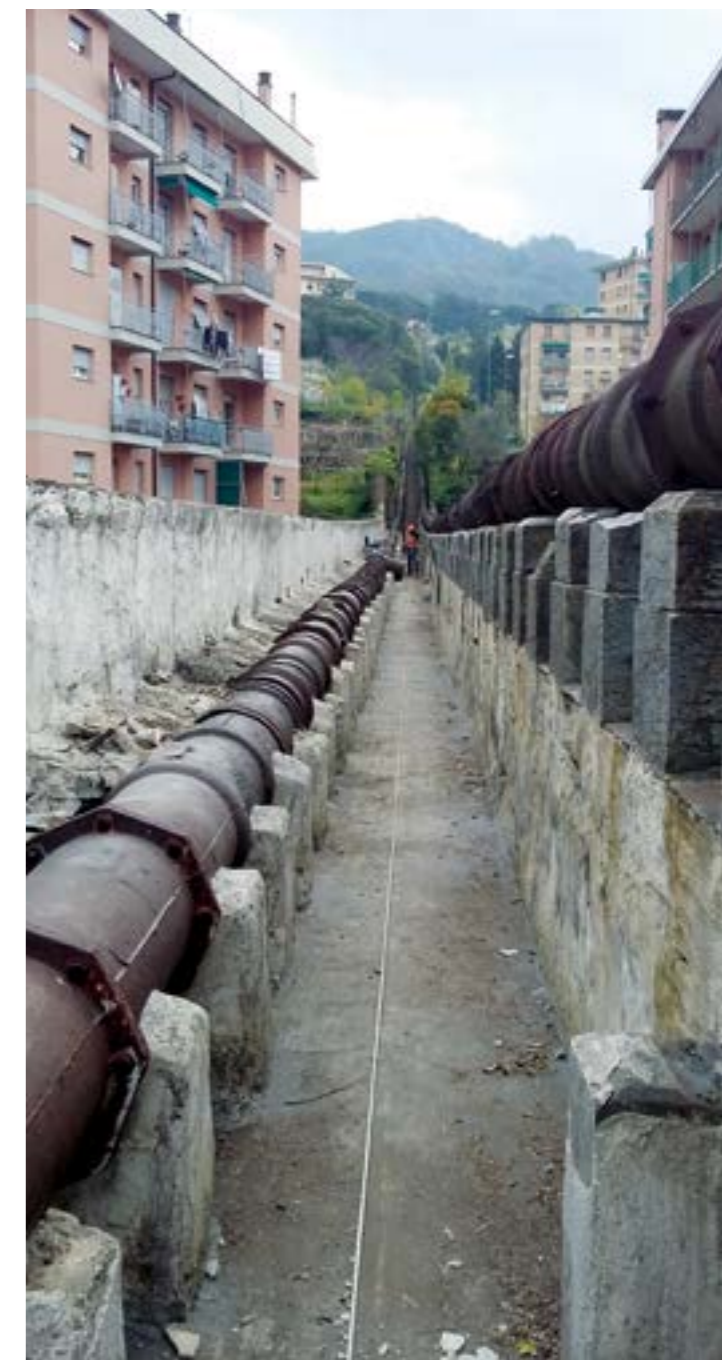
Comune di Genova. Ponte sifone sul torrente Geirato. Recupero e consolidamento strutturale.
