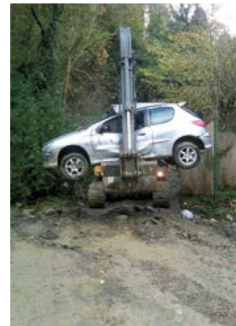
Comune di Genova. Interventi di urgenza per ripristino di movimenti franosi e sistemazione dell'alveo del torrente Chiaravagna in località Gneo Inferiore Genova Sestri Ponente.
