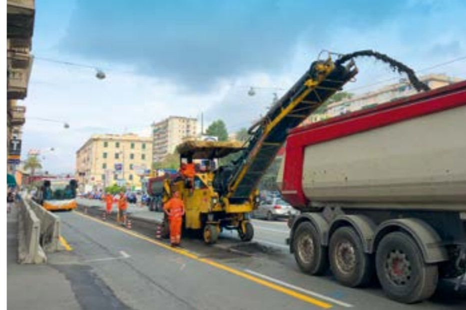
Comune di Genova - Città per Cornigliano - Sviluppo Genova SpA. Riqualificazione di via Cornigliano. Sottoservizi e viabilità urbana.
