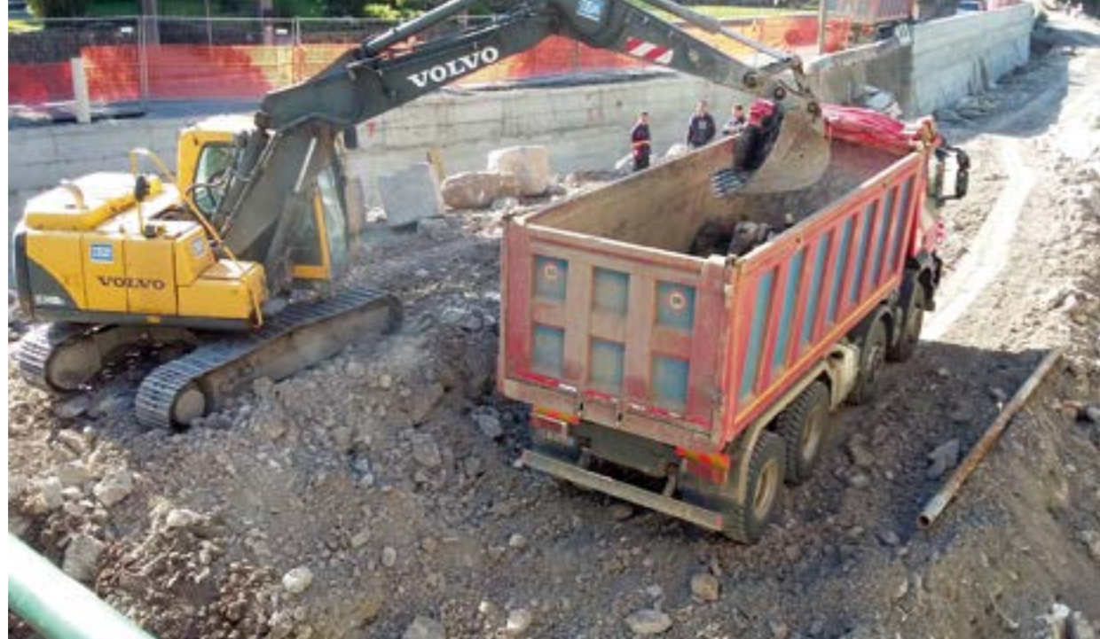
Comune di Genova. Interventi di urgenza per il ripristino dell'alveo, della relativa arginatura e protezione spondale del rio Torbido.
