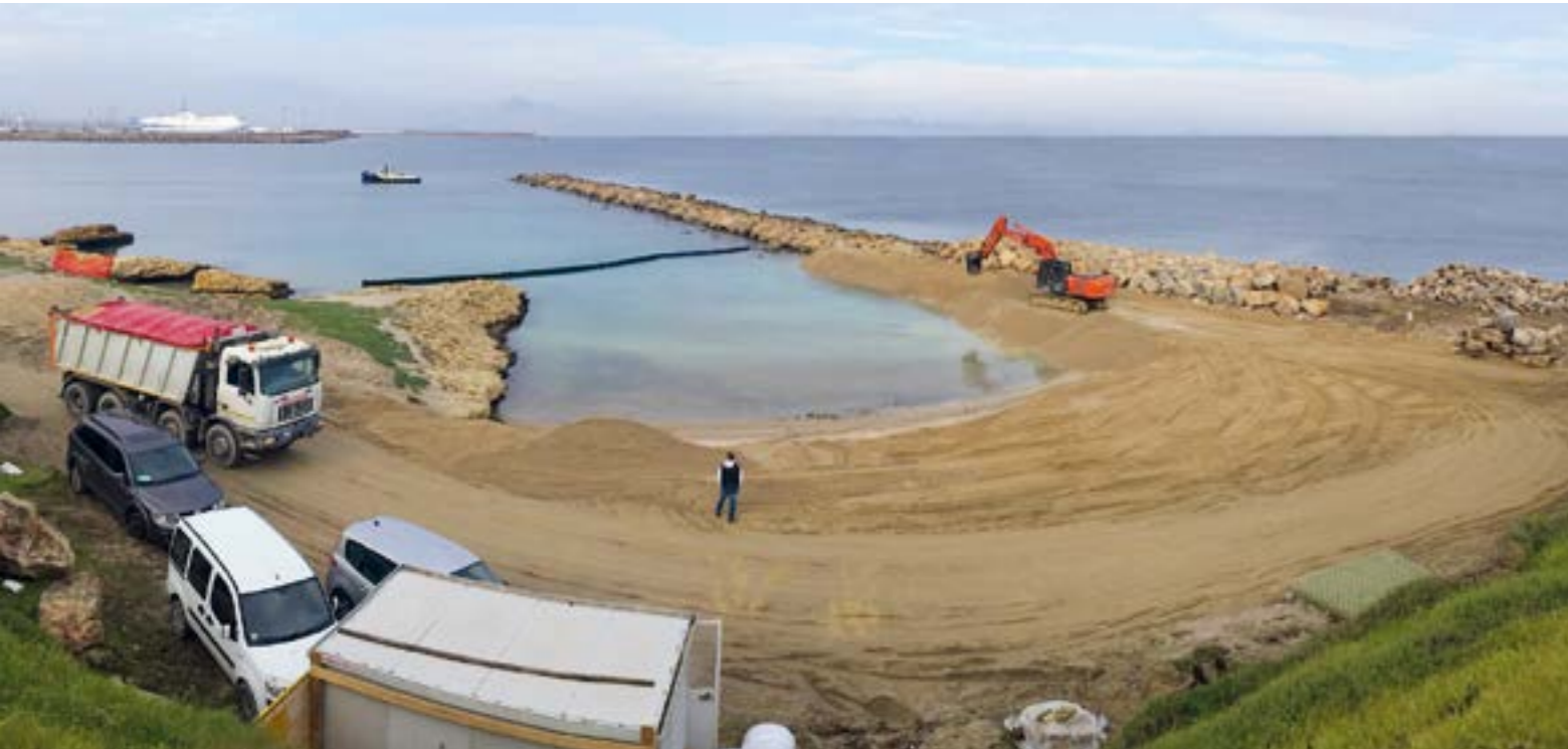
Regione Sardegna - Comune di Porto Torres. Interventi di salvaguardia della fascia costiera in località Balai. Rinforzo della scogliera, ripascimento della spiaggia e realizzazione di scogliere soffolte.
