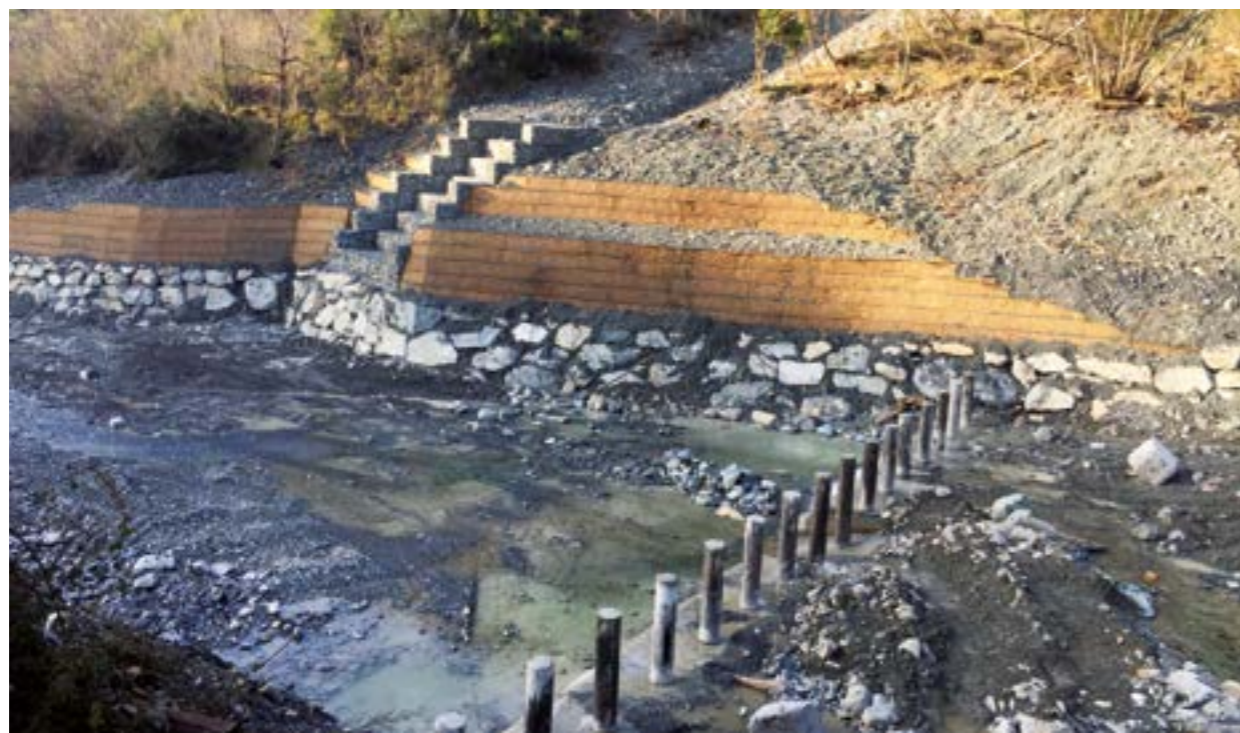
Comune di Genova. Opere idrauliche e strutturali di arginatura del torrente Varena e costruzione della nuova passerella pedonale in località San Carlo di Cese.
