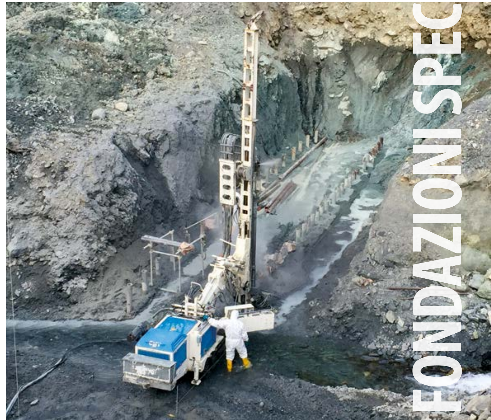
Comune di Genova. Opere idrauliche e strutturali di arginatura del torrente Varenna, esecuzione di fondazioni speciali della briglia di monte in località San Carlo di Cese.
