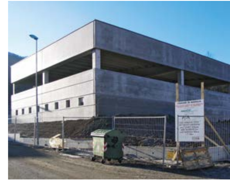
Indemar SpA - Busalla - Genova. Costruzione di nuovo capannone per ampliamento sede.
