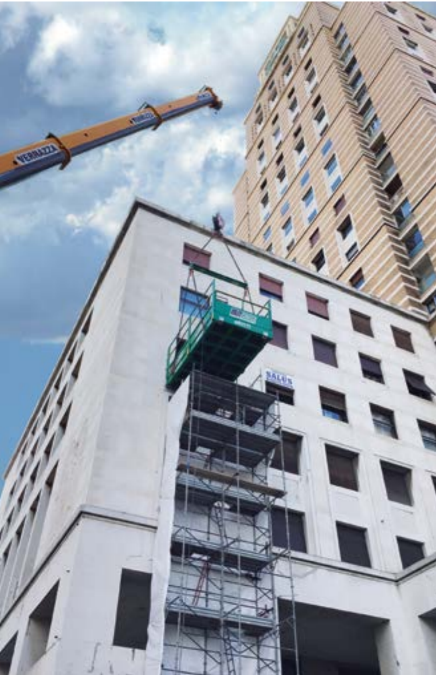
Alliance Medical SpA - Genova. Lavori per installazione nuova Risonanza Magnetica. Istituto Salus - Sede di piazza Dante.
